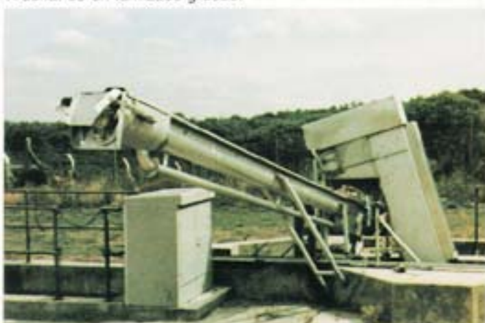
Detrás de un Tamiz, transporte y compactado simultáneos de los rechazos separados mediante un Tomillo de gran longitud.
