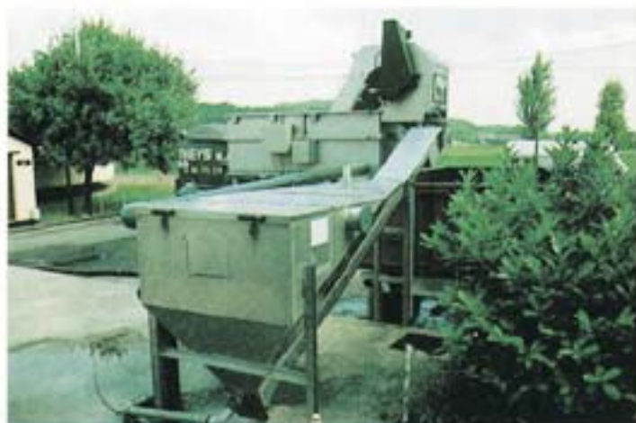
Desarenado en el vaciado de fosas sépticas. Al fondo, tamizado previo.
