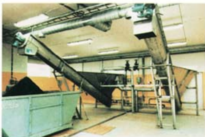
Conjunto de 2 Clasificadores de Arenas en una planta de depuración de aguas residuales urbanas.
