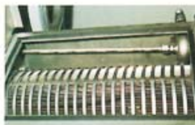
Zona de compactado con rampa de limpieza.
