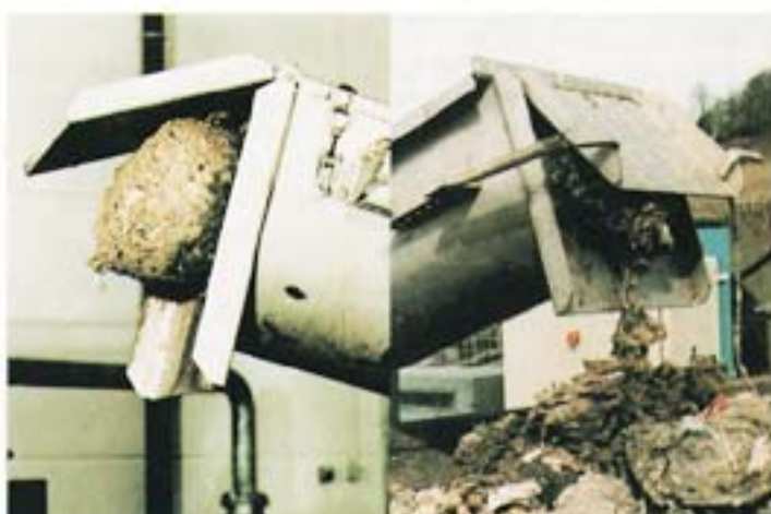
Aspecto típico de los rechazos compactados A izda. procedentes de un tamizado fino. A dcha. de un tamizado grueso.
