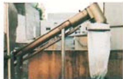
Vista del conjunto con el ensacador trabajando.
